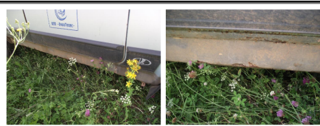
Фото 9, 10: Порог правой боковины кузова поражен коррозией до образования отверстий и трещин.
