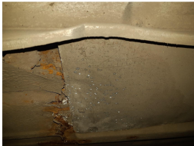
Фотография № 18. Автомобиль ласковой LADA 211440 SAMARA (нижняя часть кузова)
